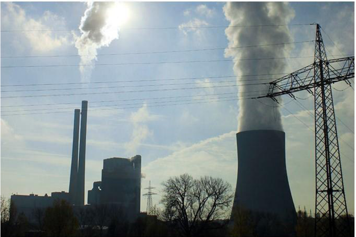
EnBW-Kohlekraftwerk Heilbronn - Foto: Helge May
